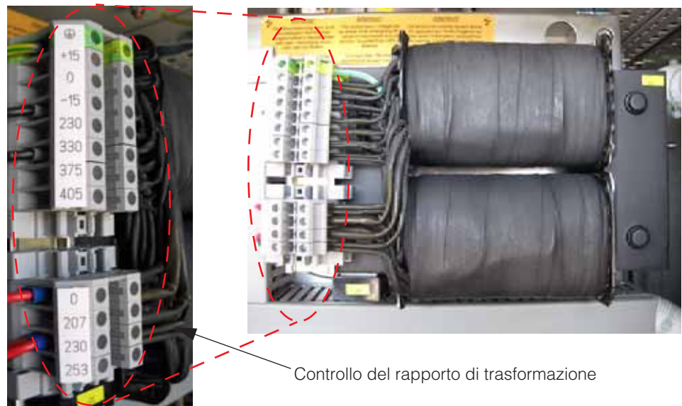
Figura 3-8 Cablaggio primario e secondario trasformatore controllo (-T6)
