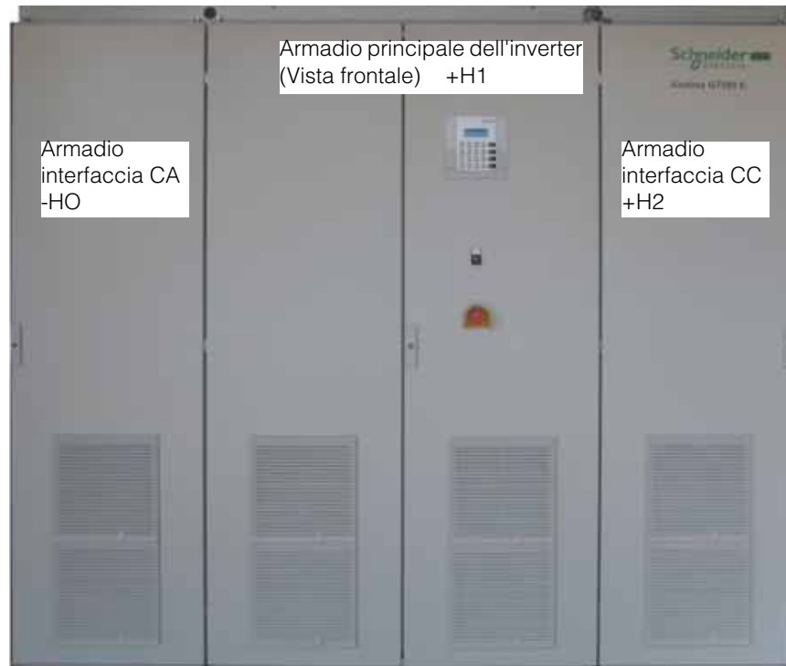
Figura 1-1 Componenti principali dell'inverter Xantrex
